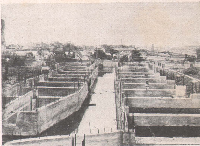
Відбудова японської столиці Токіо по недавнім землетрусі поступає дуже швидко. Вже 10.000 домів готових. Тут основи під новий госпіталь св. Луки.
