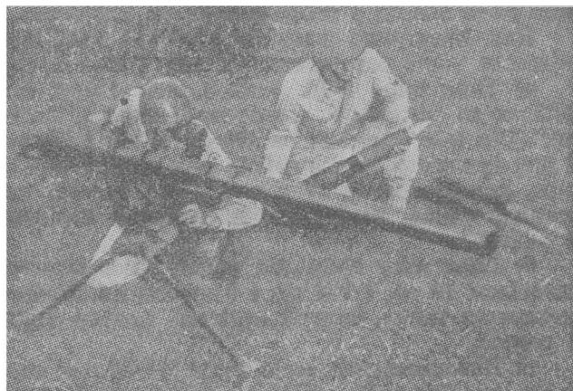
„Старший брат” безвідштовхової гармати. Карабі. 75 мм. Довжина 2,46 мтр. Вага 48,50 кгр. Стріляє гранатами високорозривної конструкції вагою 6,30 кгр. Має телескопний і поземний прицільний прилад. Достріл понад 4.000 мтр.
