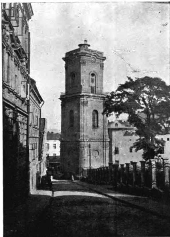
Вежа при вул. Владичій з 1776. р.
