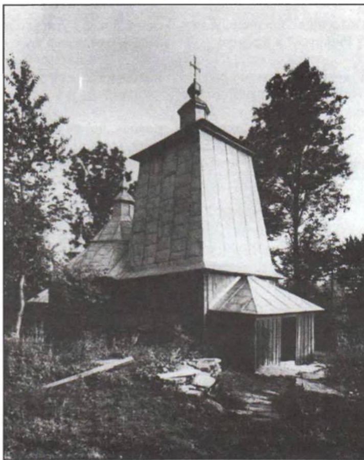
Балутянка, Польща. Греко-католицька церква, біля 1820 р. Вид від півн.-заходу.
