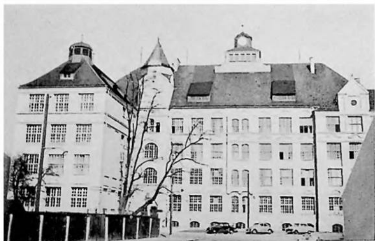
Будинок школи в Мюнхені з приміщенням УВУ.
