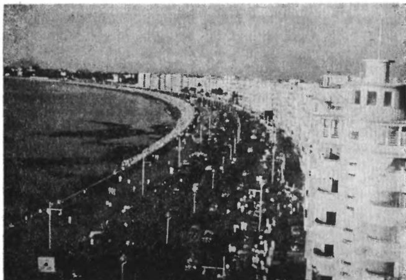
ІНДІЯ, Бомбай. Прекрасний великий бульвар Марін Драйв, що тягнеться здовж моря, та великі будівлі різних компаній і мешканеві каменниці при ньому.
