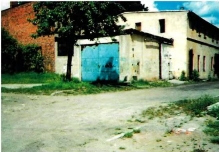
22. Adaptacja przedwojennej winiarni na cerkiew - stan początkowy.
