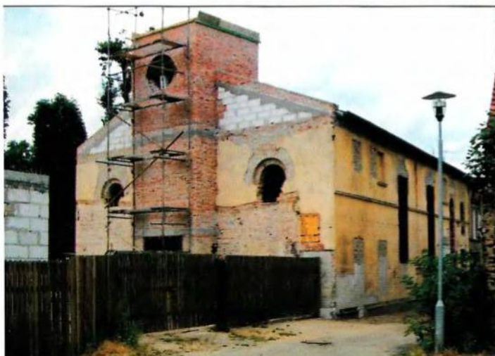
24. Budowa cerkwi. Stan na koniec lipca 2006 r.
