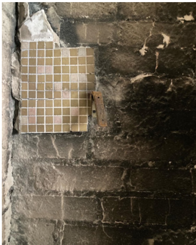
Ірпінь. Інтер'єр зруйнованої квартири Катерини Яковленко. Фото: Катерина Яковленко, 2022.
