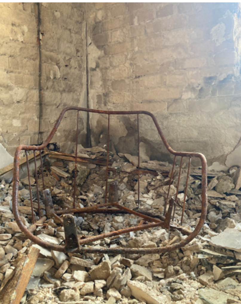
Ірпінь. Інтер'єр зруйнованої квартири Катерини Яковленко. Фото: Катерина Яковленко, 2022.
