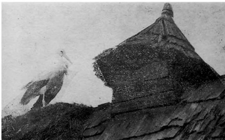
33. Боглярка № 31. Фрагмент даху із стрішкою над коином. Фотоархів МУК.
