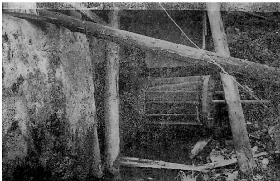
27. Лівов № 57. Фрагмент водяної пили — водяне колесо. Фотоархів МУК.
