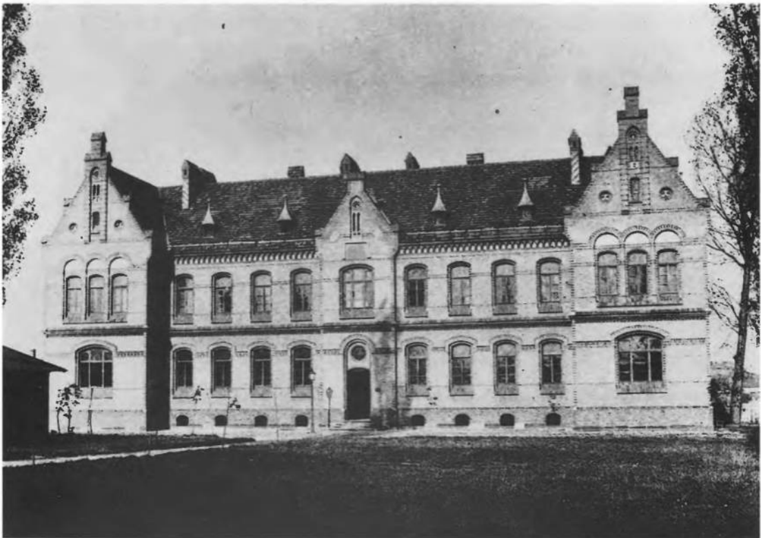
75. Будинок для невиліковувано хворих фундації Білінських, вул. Білінських (тепер Смаль-Стоцького), проект Юліуш Гохбергер, будував Іван Левинський, 1893-1895
