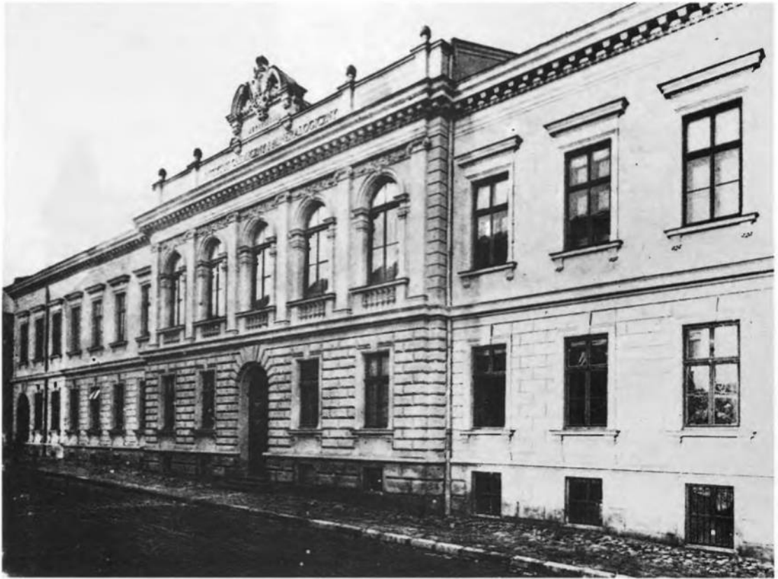
57. Uniwersytecki Instytut Chemiczno-Mineralogiczny, ul. Długosza (dziś Cyryla i Metodego), proj. arch. wiedeński Risori, bud. Józef Braunseis, 1892
