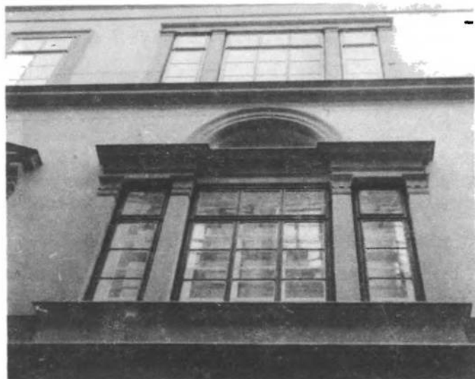
Перший поверх будинку. Приміщення домівки "Січі"
