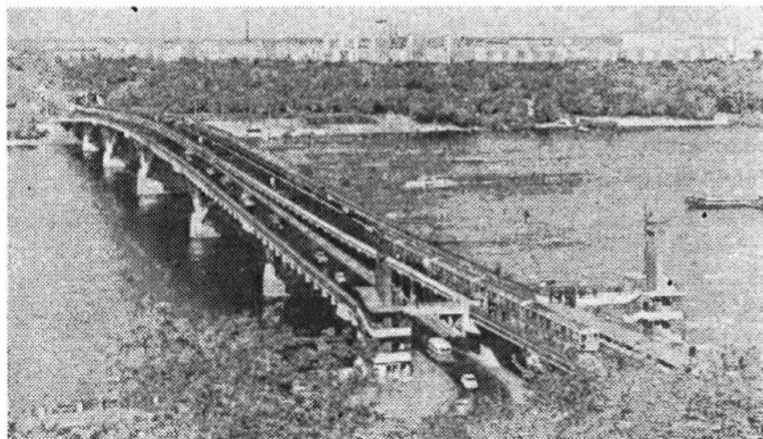
Київ. Метроміст через Дніпро.
