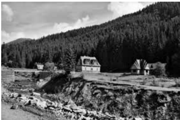
51. Nový most přes řeku Tereblju. Podobně se budovala i stavidla. Foto DK, 2002.
