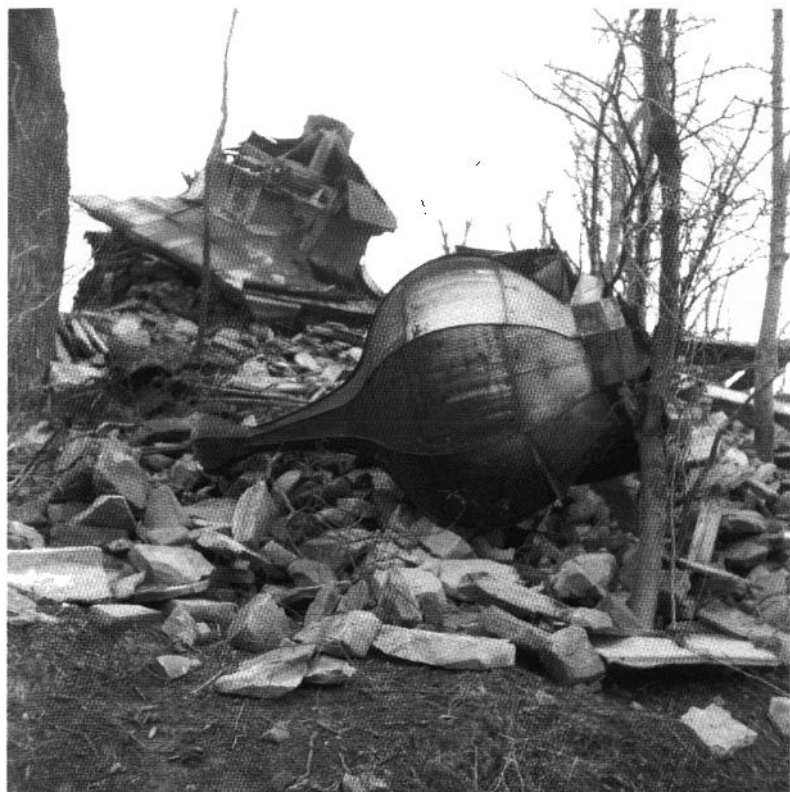
Pozostałości cerkwi w Rajskim, wysadzonej w powietrze na polecenie Służby Bezpieczeństwa w 1980 roku. fot. Eta Zaręba
