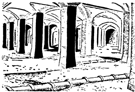
Мал. 18. Внутрішній вигляд міського фільтра, з якого видалено пісок (з фотографії).
