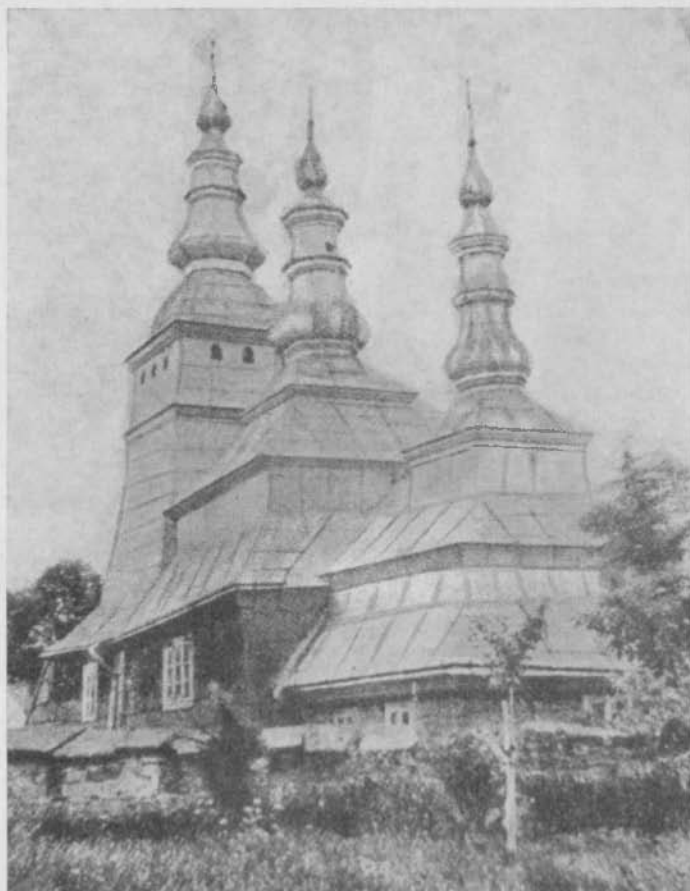
Церква Покрови Пресв. Богородиці в Рихвальді, повіт Горлиці, побудована в 1653 р., відновлена в 1849 році
