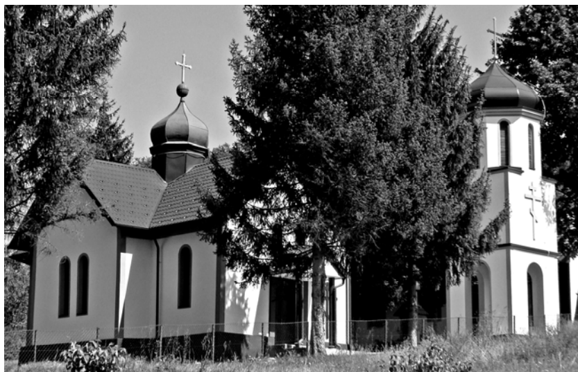
Dabrack 2013. – zvonik i crkva Pokrova Presvete Bogorodice (Fot. A.P.)
