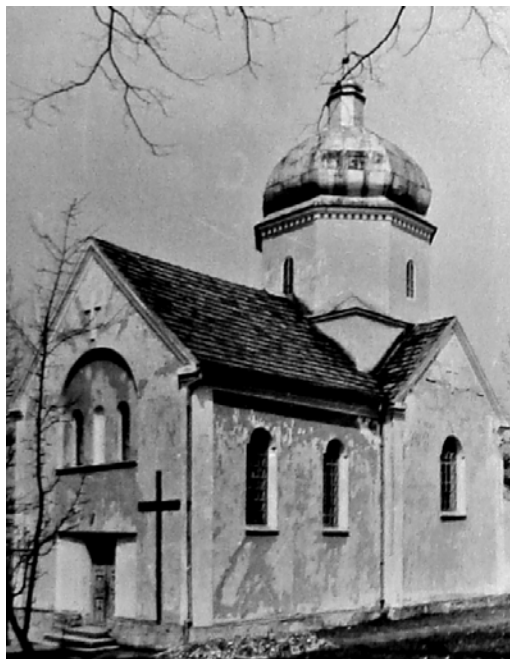
Crkva Uspenija Presvete Bogorodice u Devetini s tragovima sanacije nakon velikog potresa 1969. godine
