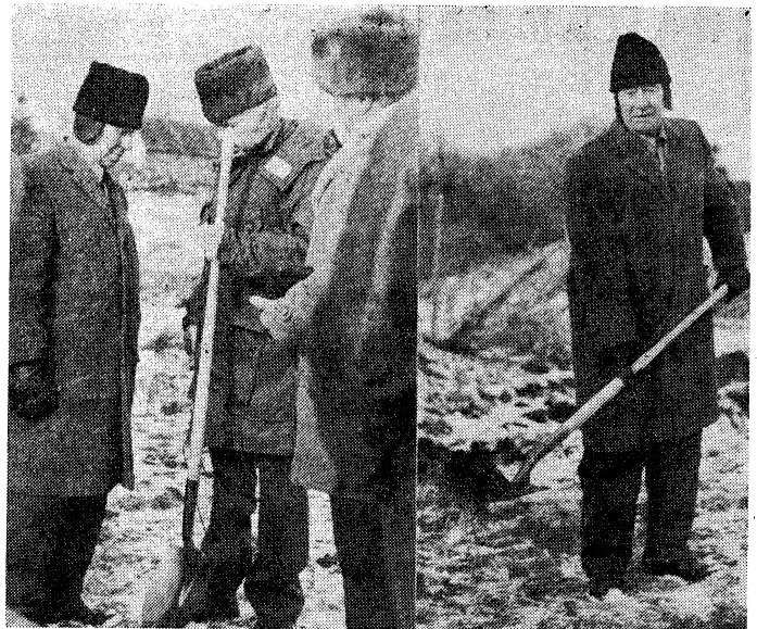
Голова Головної Управи ТОП Канади Ів. Данильченко в присутності голови Будівельного Комітету Миколи Співака передає лопату меценатові ОДУМ-у Василю Тацюкові для зворушення землі під будову таборового будинку.
