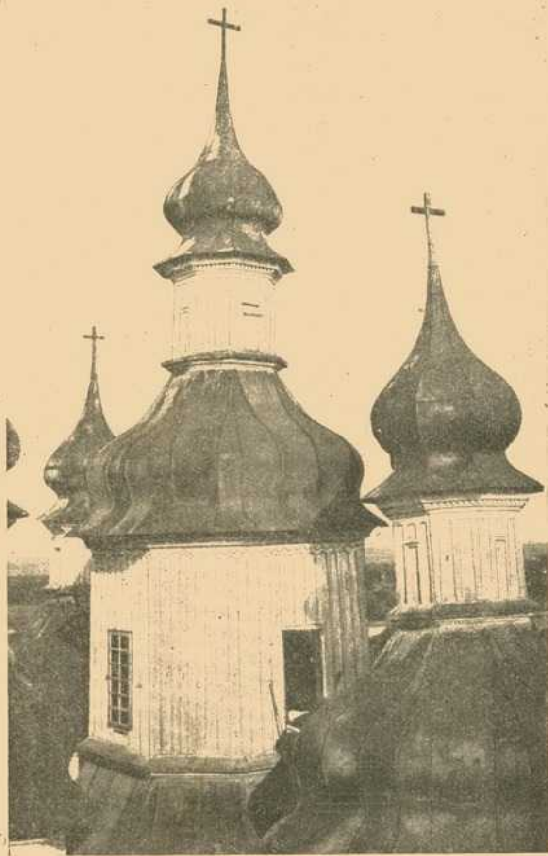
Рис. 1. Кровля куполовъ Покровской церкви.
