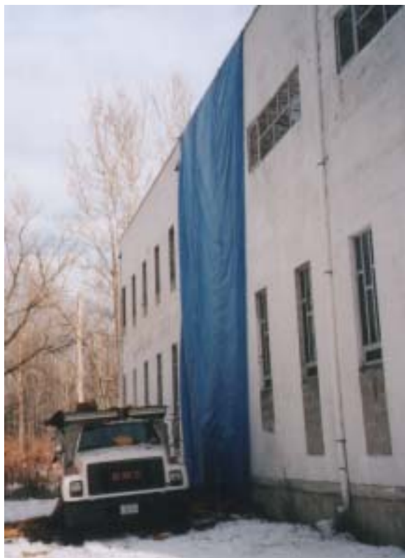
Вигляд Святині ззаду, під час робіт на даху.
