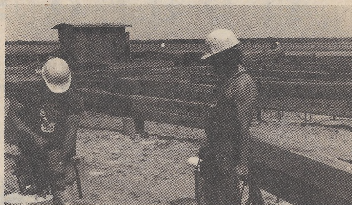
Construction of stage - May-June, 1984. Будова сцени — травень-червень 1984 р.
