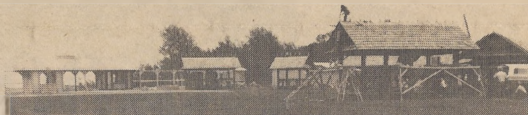
Construction of festival kiosks. Будова кіосків для фестивальної площі — серпень 1984 р.
