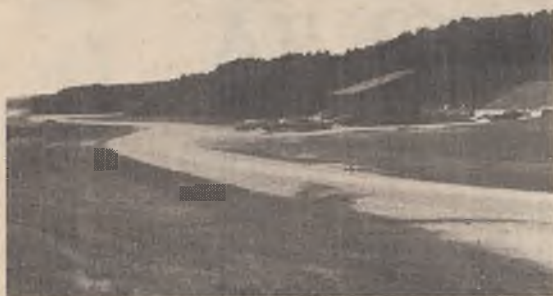
Construction of road to site completed - September, 1984. Новозакінчена дорога до площі — вересень 1984 р.
