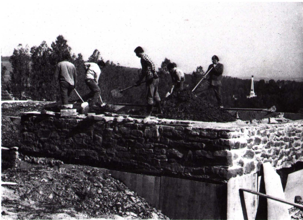
На будівництві скансену Na výstavbe skanzenu
