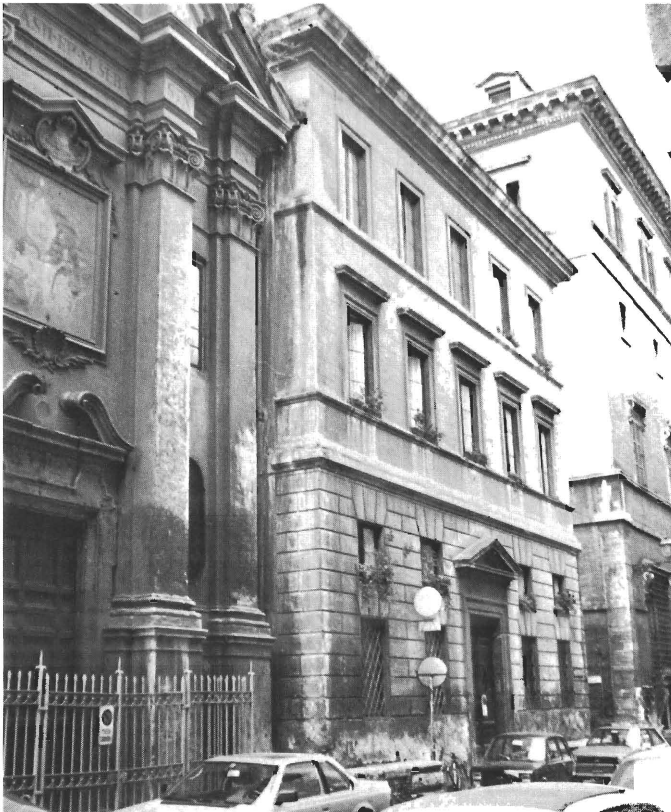
Будинок на віа Джулія побіч церкви св. Власія, в якому жив Київський Митрополит Ісидор Residence of Kievan Metropolitan Isydor on via Giulia next to the St. Blasio church
