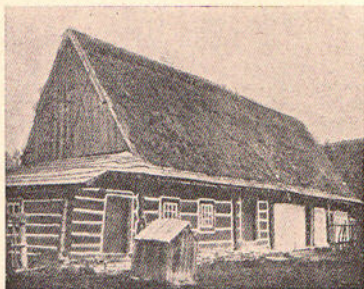
Деревяна хижа з керницею без журавля.
