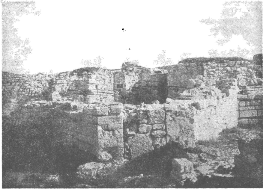
Руїни херсонеських будов. Спосіб мішаного мурування, т. зв. opus mixtum (цегла з каменем), що пізніше вживався в київських будовах X—XI ст.
