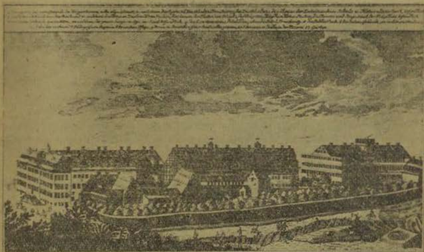
Ansicht des Sprit-Hauses in Halle
