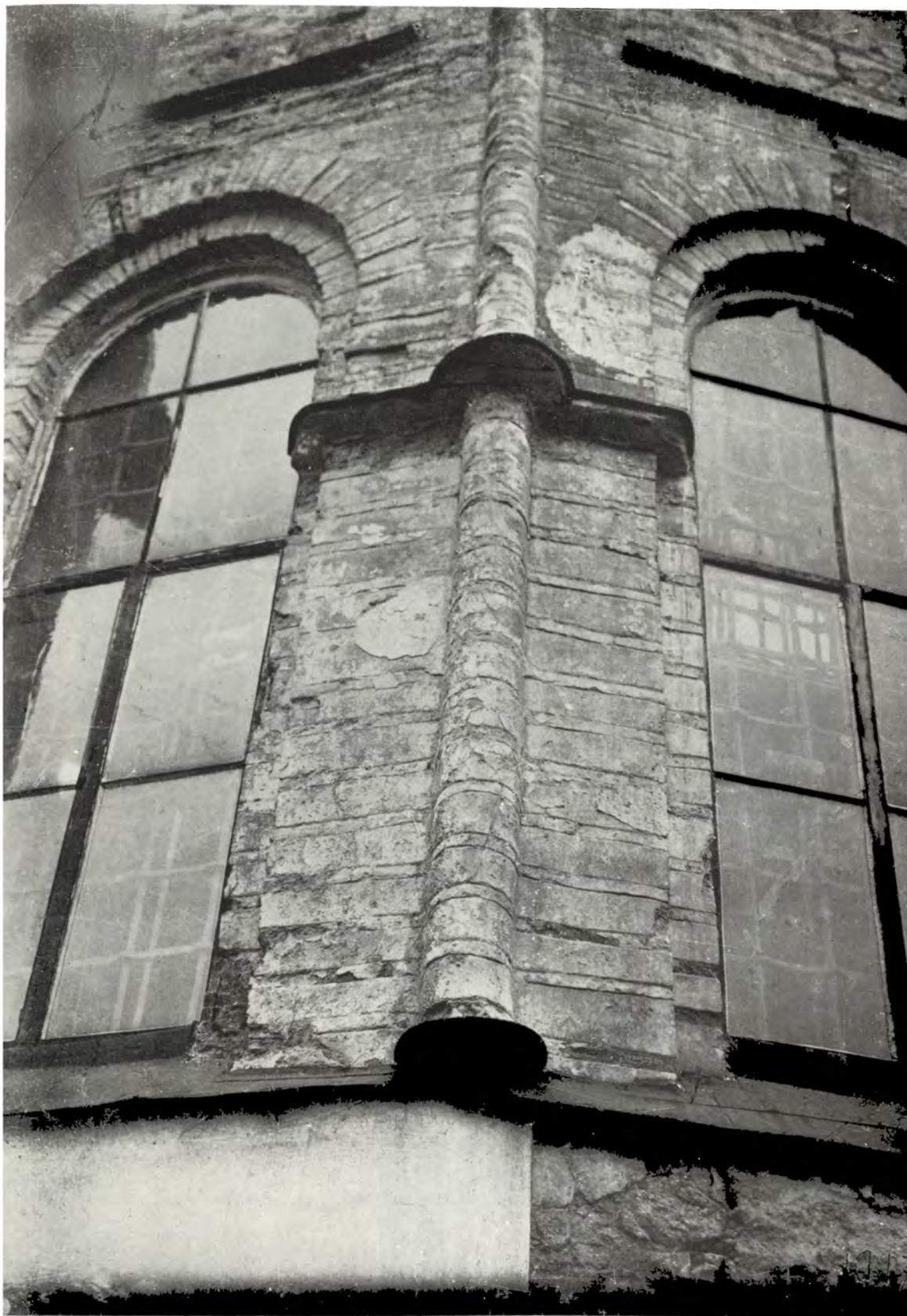
Exterior walls with plaster removed — main apse. Стіни головної апсиди після очищення їх від тинку.
