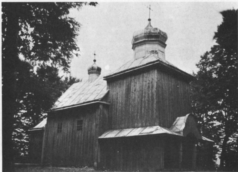
40. Речпілѣ (пов. Перемишль), церква Покрова Пр. Б. 1870. Reszpol, 1870.
