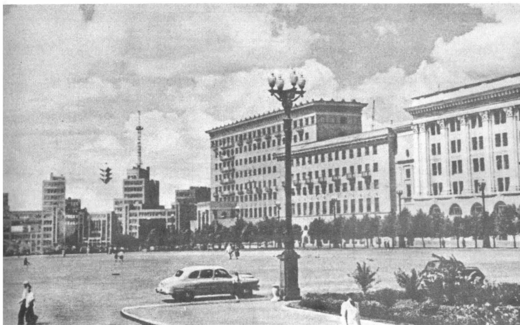
Харків. Центральна площа.
