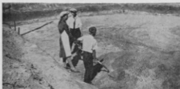
Копують площу під будівлю Українського Національного Дому в Саскатуні.
